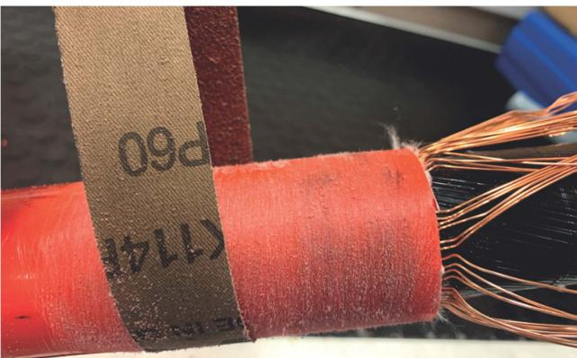
El objetivo de esta técnica es preparar una zona longitudinal de la cubierta del cable, en los extremos del accesorio, para que el elemento utilizado para el sellado contra la entrada de agua, se adhiera correcta y completamente a dicha cubierta de cable, asegurando así la adherencia y, por tanto el sellado.
